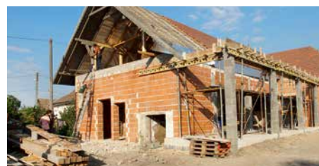
keuken in aanbouw
